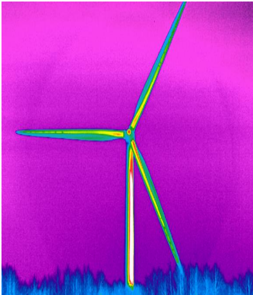
IR thermografische Aufnahme einer Windenergieanlage
